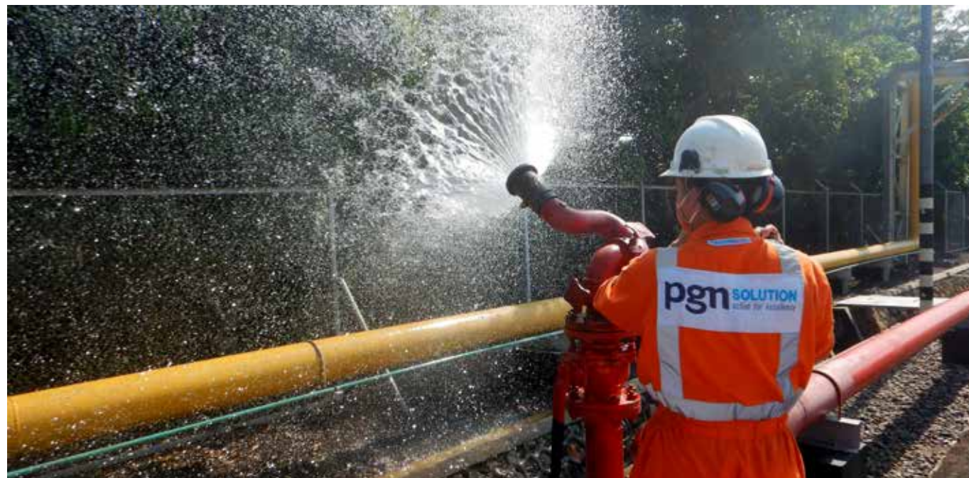
Tim O&M Stasiun Pagardewa melaksanakan pengecekan dan test run fire hydrant di Area Stasiun Pagardewa. Kegiatan ini rutin dilakukan setiap sebulan sekali untuk menjaga performa equipment.
