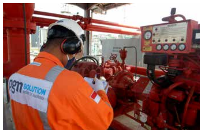
Tim O&M Stasiun Pagardewa melaksanakan pengecekan dan test run fire hydrant di Area Stasiun Pagardewa. Kegiatan ini rutin dilakukan setiap sebulan sekali untuk menjaga performa equipment.
